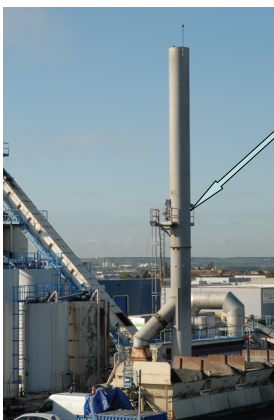
Analyseur à ionisation de flamme pour quantification du méthane et des composés organiques gazeux
