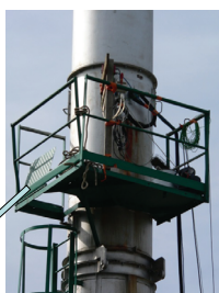
Plate-forme de prélèvement équipée
